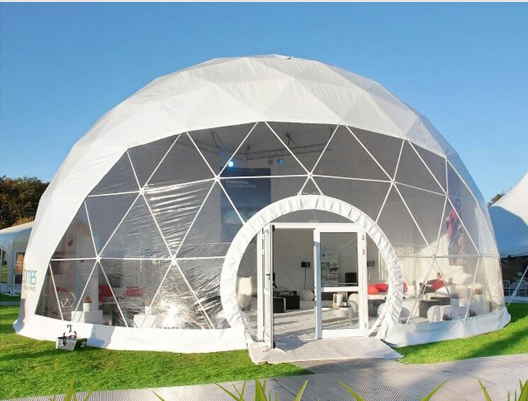
Конструкция собрана из стрелней, скрепленных вместе, и в целом представляет собой геодезическую структуру: все грани сферы соединены между собой и представляют единую конструкцию с металлическим каркасом и легкой ПВХ-оболочкой.
